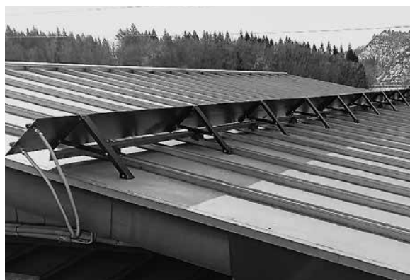
常春システムを設置した屋根の様子
